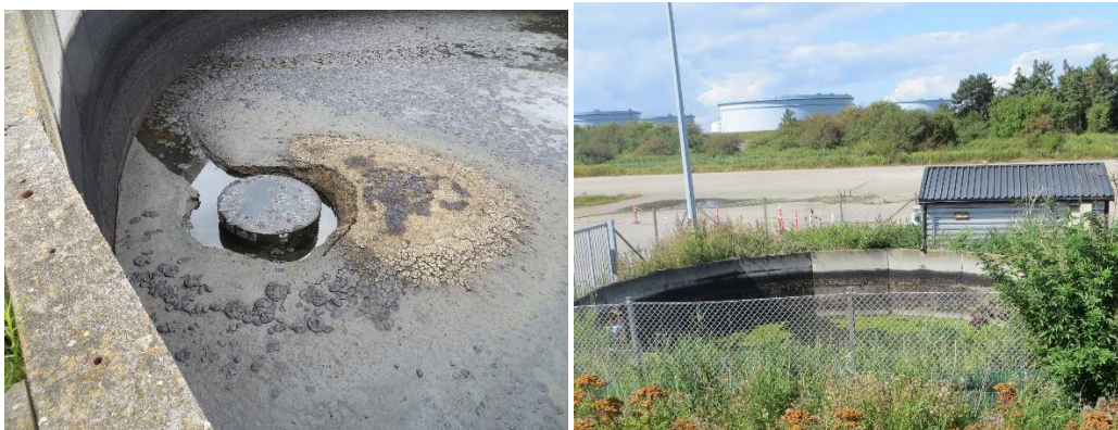
Perkolattank nye slamplads og perkolattank gamle slamplads.
