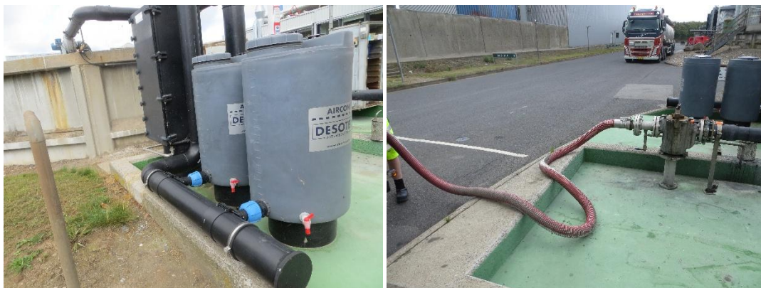
Kulfiltre på modtagetank 13.01
