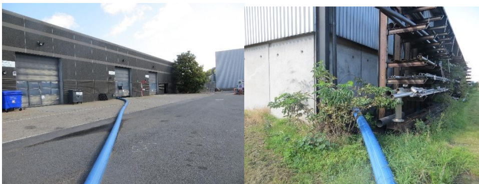
Midlertidig løsning på transport af slam til Hal A.
