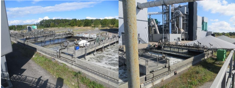
Gamle procesanlæg tank 51.01, 52.01, 52.02, 52.03 og 52.04
