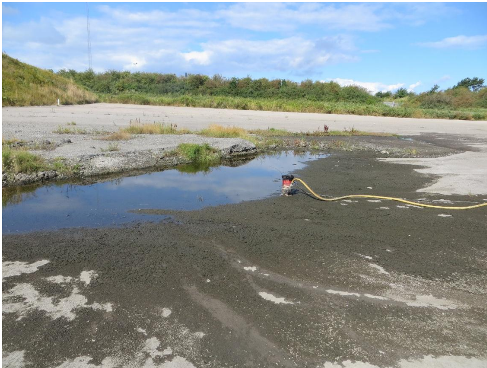
Der er opstillet mindre pumper til at pumpe overflade/grundvand til perkolattanke.
